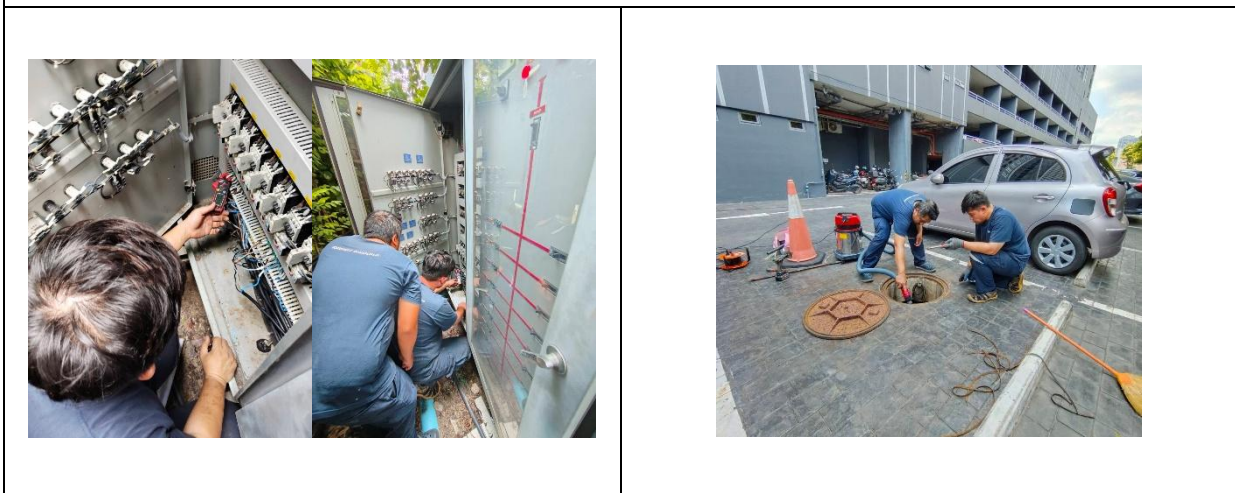
ภาพที่ 13 ระบบบำบัดน้ำเสีย ยิงชีลีโคนปิดฝาป้องกันกลิ่นย้อนกลับ
