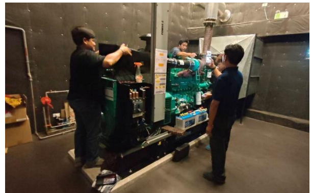
ภาพที่ 26 เครื่องกำเนิดไฟฟ้าสำรอง
