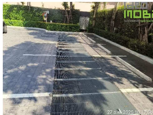
ภาพที่ 16 ตะแกรงคัดขยะที่ Man Hole สุดท้าย
